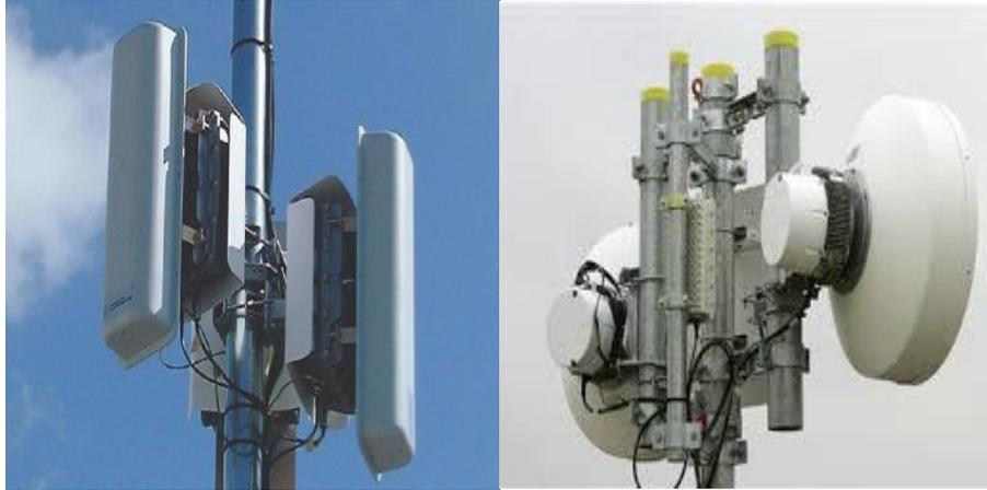
**Figure 5.2 :** Deux antennes relais associées au LTE et WiMAX.
