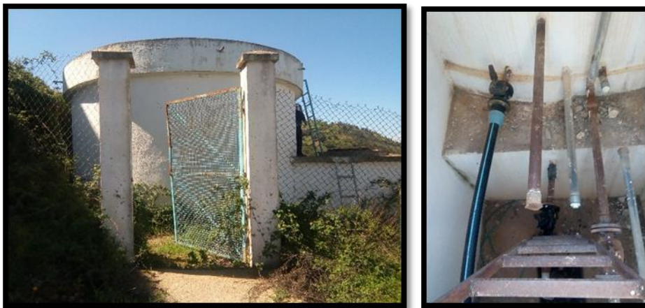
Figure (III.6) : Vue extérieure du réservoir de Belias et la chambre de vanne
