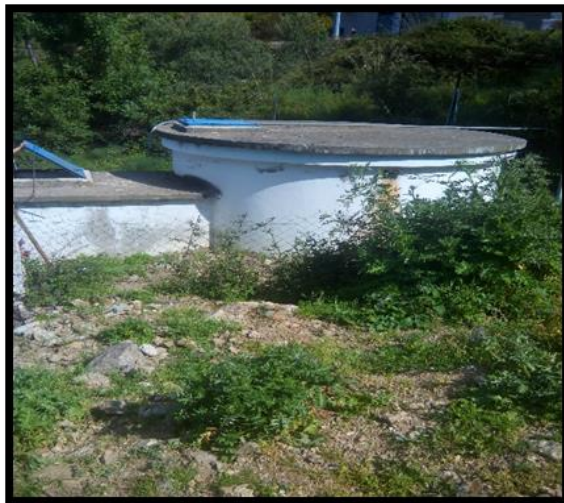
Figure (III.8) : Vue extérieure du réservoir de Charaioua
