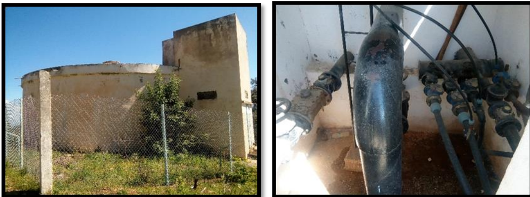
Figure (III.5) : Vue extérieure du réservoir d'Afensou et la chambre de vanne
