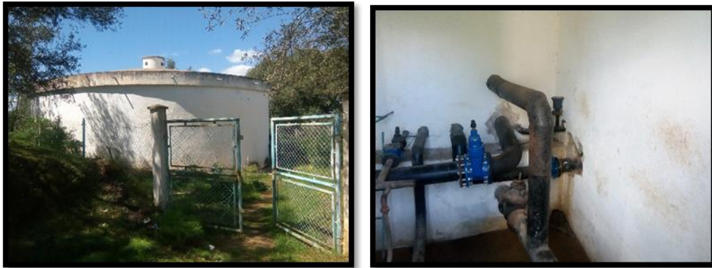
Figure (III.10) : vue extérieur du réservoir de Tala Amara et la chambre de vanne
