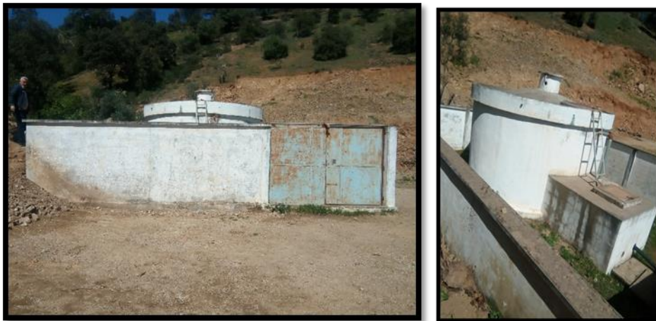
Figure (III.7) : Vue extérieure du réservoir d'Igounane et la chambre de vanne
