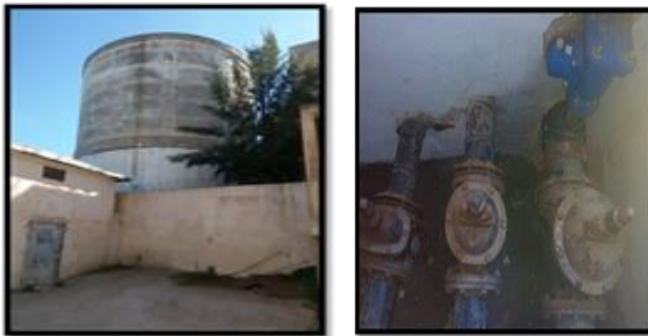
Figure (III.3) : Vue extérieure du réservoir de Boushel et la chambre de vanne
