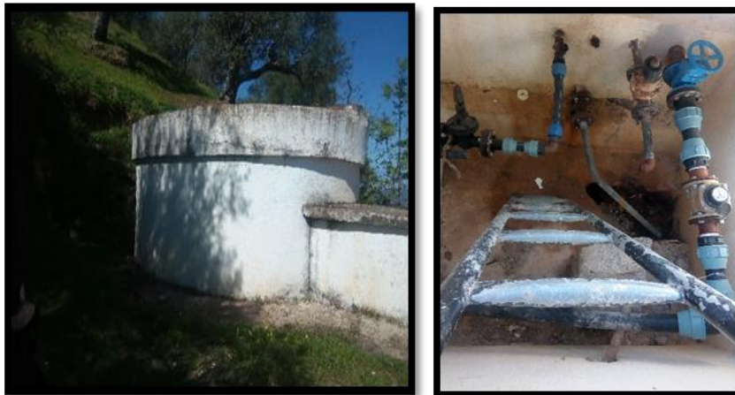
Figure (III.9) : Vue extérieure du réservoir d'Amalou et la chambre de vanne
