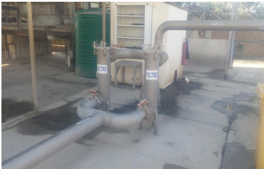
Figure N°5 : Photo montrant un filtre à tamis (Cliché Achiou, 2017).
