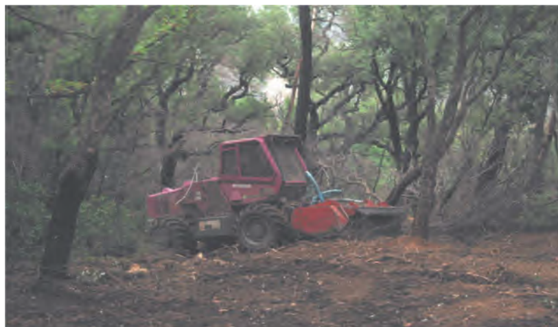
Figure 12 : image des travaux de broyage de la végétation basse.
