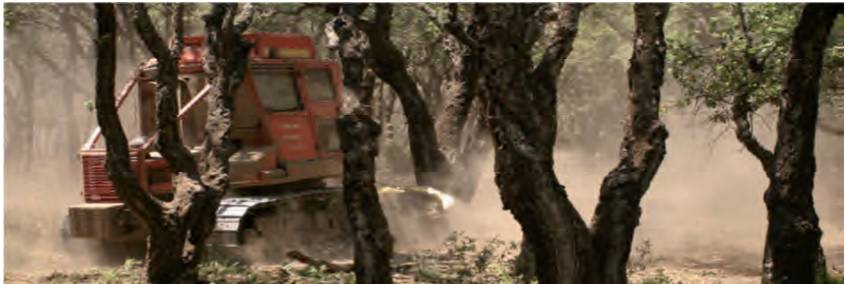
Figur13. Image des travaux du broyeur d'entretien.
