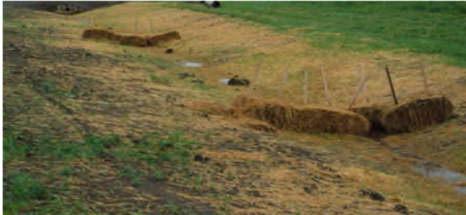
Figure 23 : Image de technique des ballots de paille contre l'érosion. (RAPPEL, 2003)
