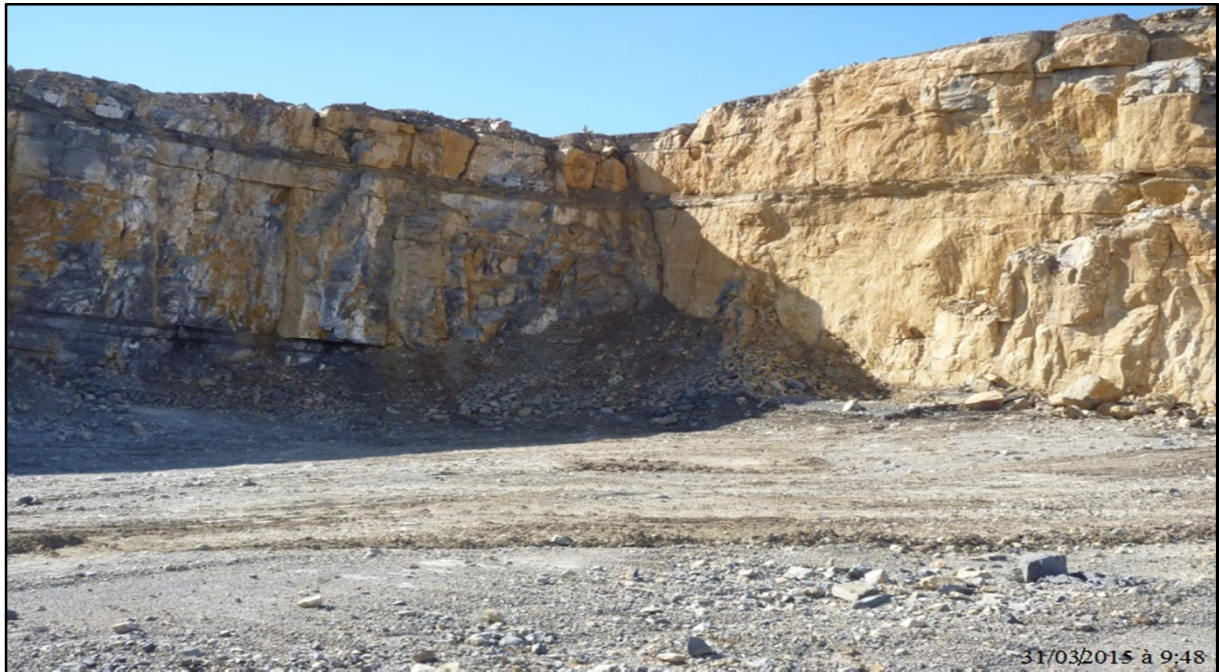
Figure V.2: Présence d'un joint subhorizontal.
