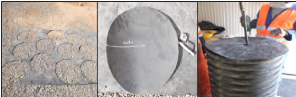
Figure F.2: La préparation du fond des colonnes et du système de récupération de la solution enceinte.
