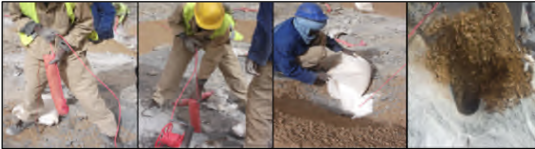
Figure B.1: Remplissage des trous de mine par les explosifs.
