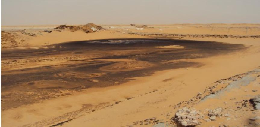
**Figure V.2 :** bourbier conventionnel (volume  $\square$  3800m<sup>3</sup>, liner de mauvaise qualité) [15]
