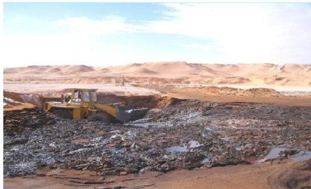
**Figure V.4 :** Chargement des déblais par pelle mécanique
