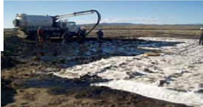
**Figure V.11** : l'utilisation de l'adsorb oil.
