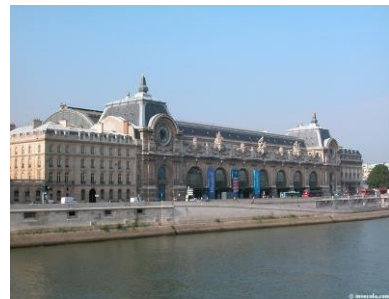
Figure 44 : Ouvertures Façade Nord du musée d'Orsay. (Source : http://façade.musée.orsay.archi.fr )
