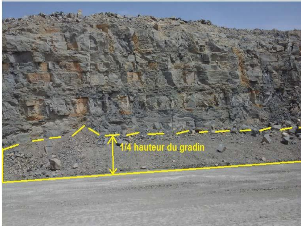
Figure V.24 : Photo qui représente une sortie de pied de gradin au niveau 980 de la carrière de Chouf Amar.
