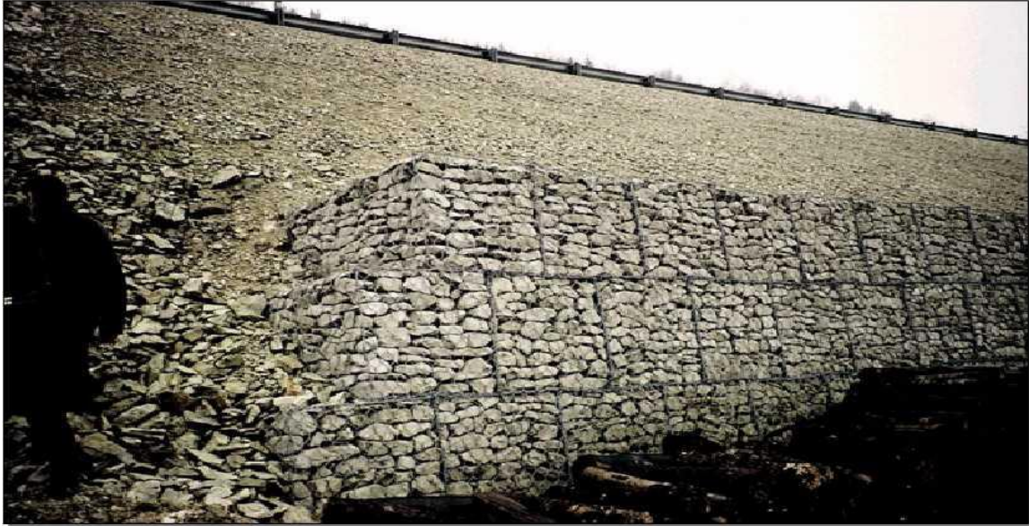
Figure I-22 : Exemple d'ouvrage souple : Mur en gabion (Service d'Etude Technique des Routes et Autoroutes (SETRA)).
