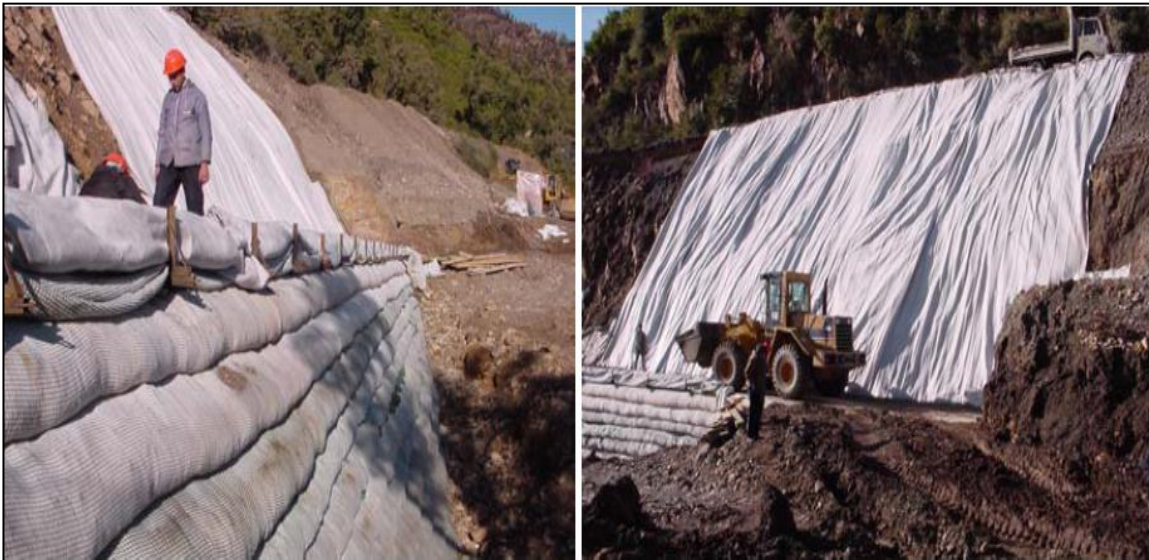
Figure I-22 : Exemple d'ouvrage souple : Mur en gabion (Service d'Etude Technique des Routes et Autoroutes (SETRA)).
