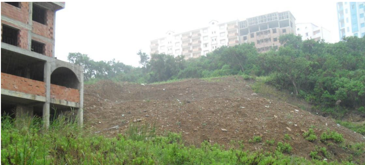
Figure I-1: Exemple d'un glissement de terrain De la cite des 50 logements mezghitane (JIJEL). [1]
