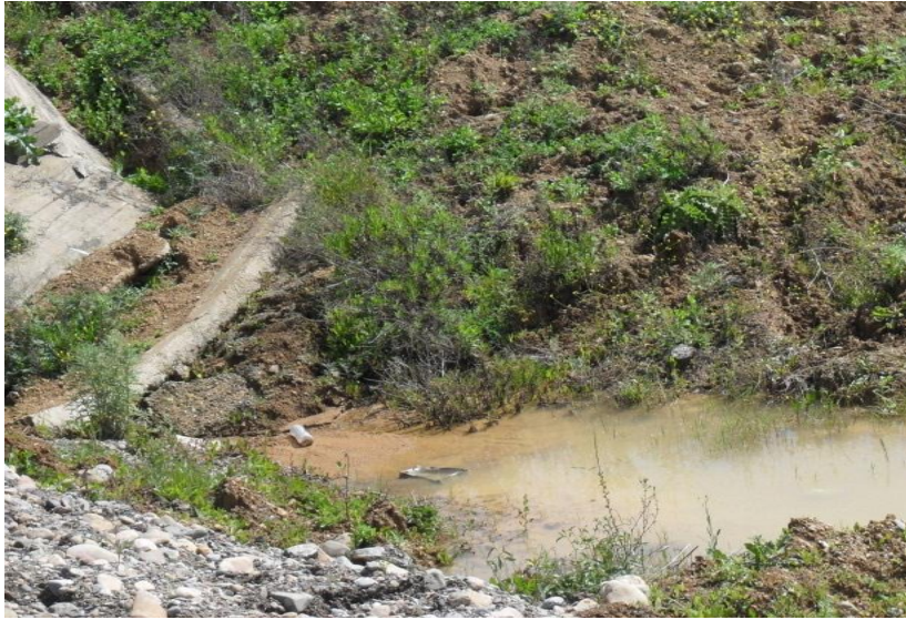
Figure II-3 : Zone de stagnation des eaux
