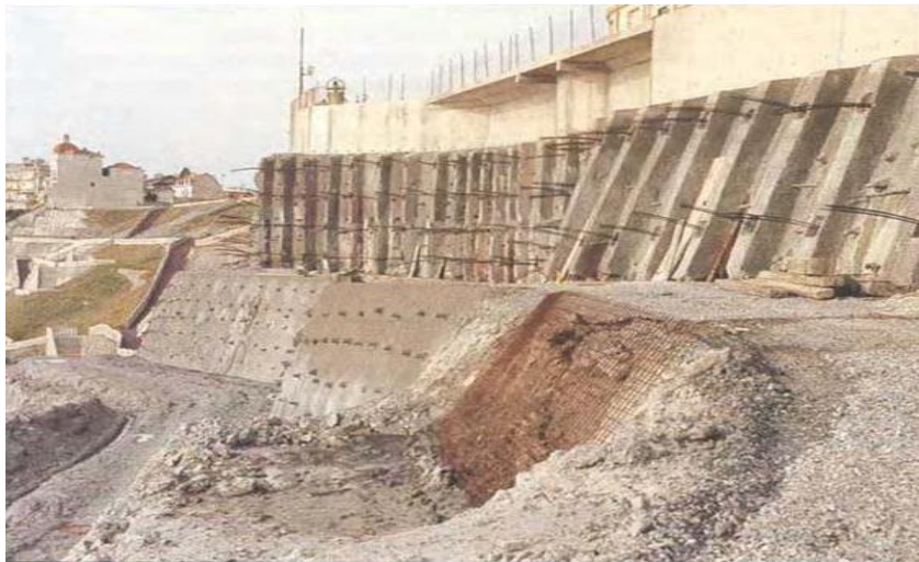
Figure I-24 : Schéma de confortation par tirants d'ancrages. [18]
