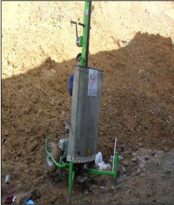
Figure II-7 : photo d'Implantation d'un sondage pénétrométrique
