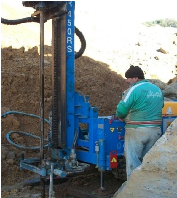
Figure II-6 : photo d'implantation d'un sondage carotté
