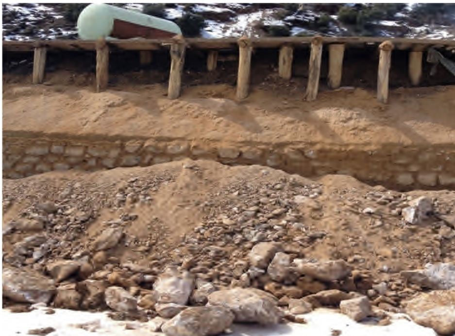
Figure II.9: plate forme de stockage du tout venant dans l'état actuel.
