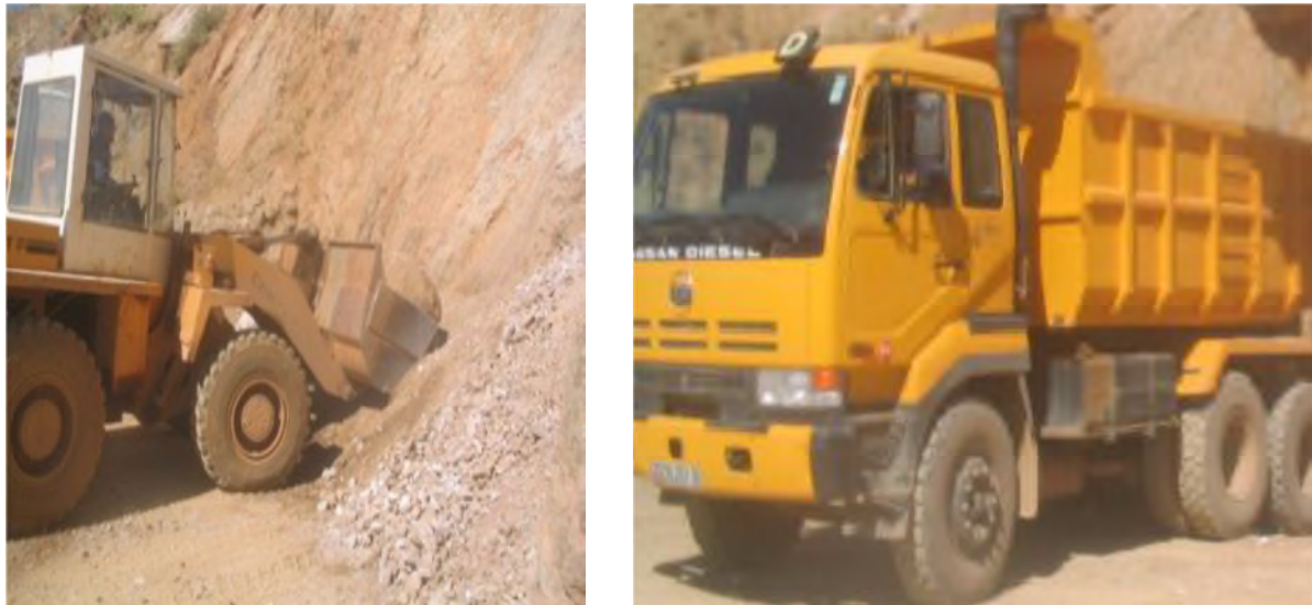
Figure II.8: pelle et camion pour le chargement du tout venant a l'exterieur de la mine[6].
