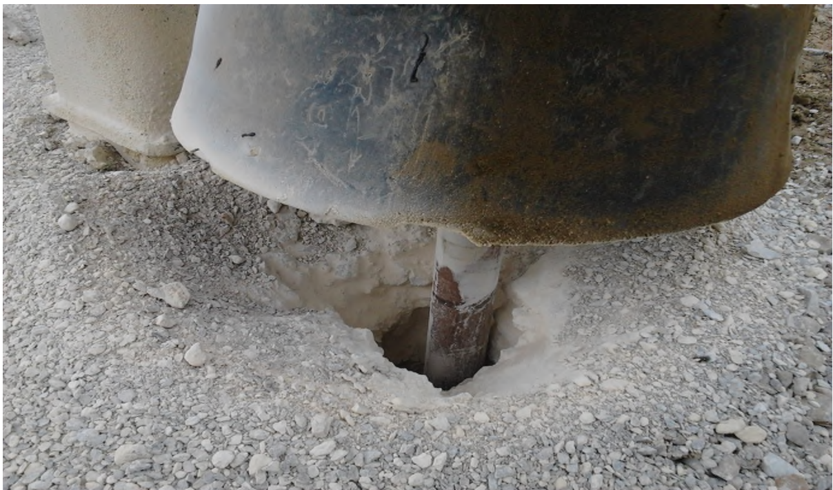
ANNEXE III : Travaux de forage
