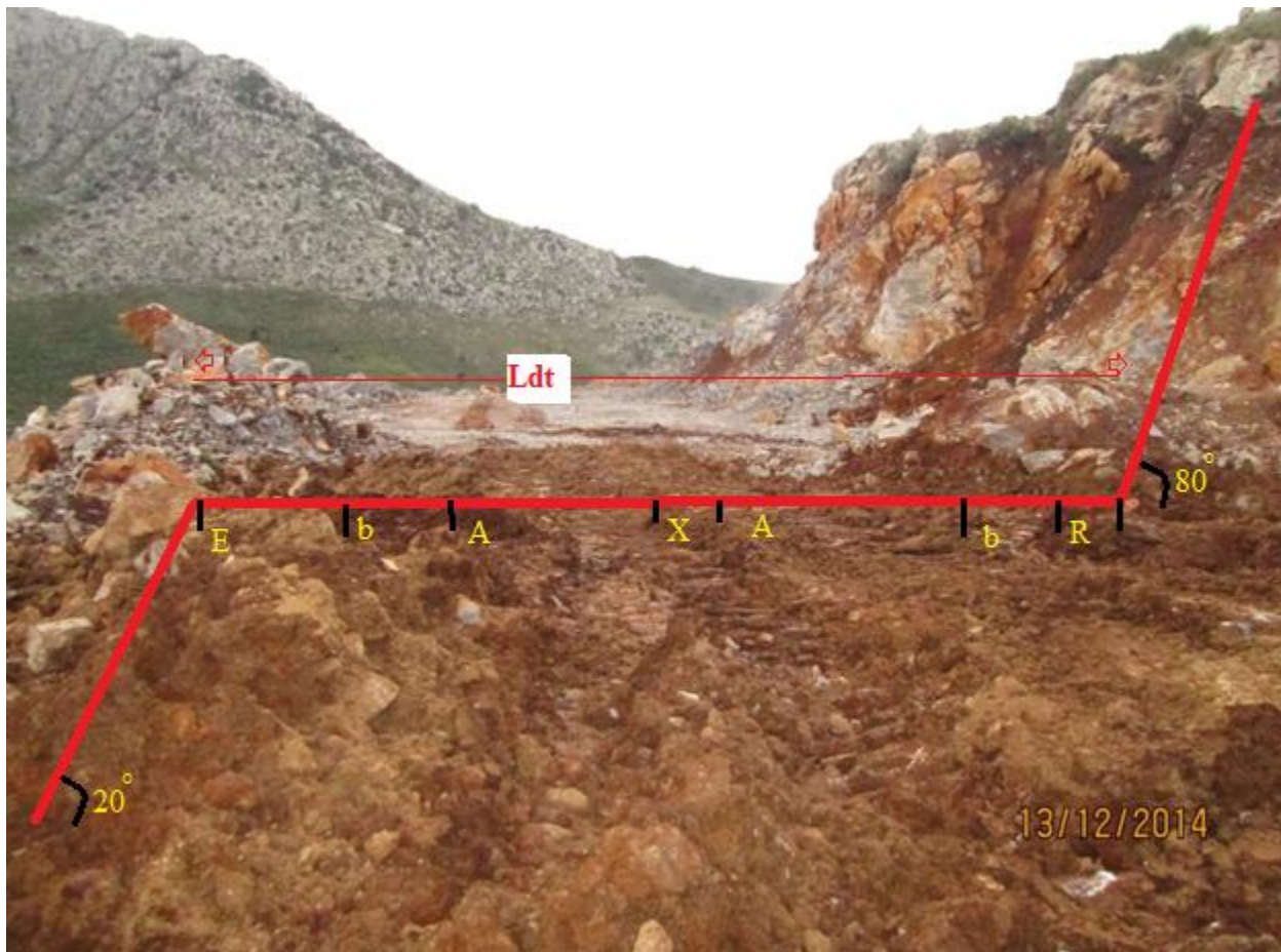
Figure II.5 : la largeur de la piste d'accès.
