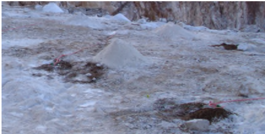
ANEXE VII : Travaux de raccordement
