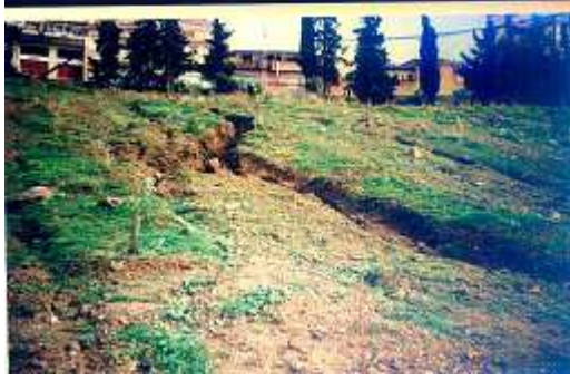
Photo n° 1 : Erosion par rigoles (El-Kseur, 2003)
