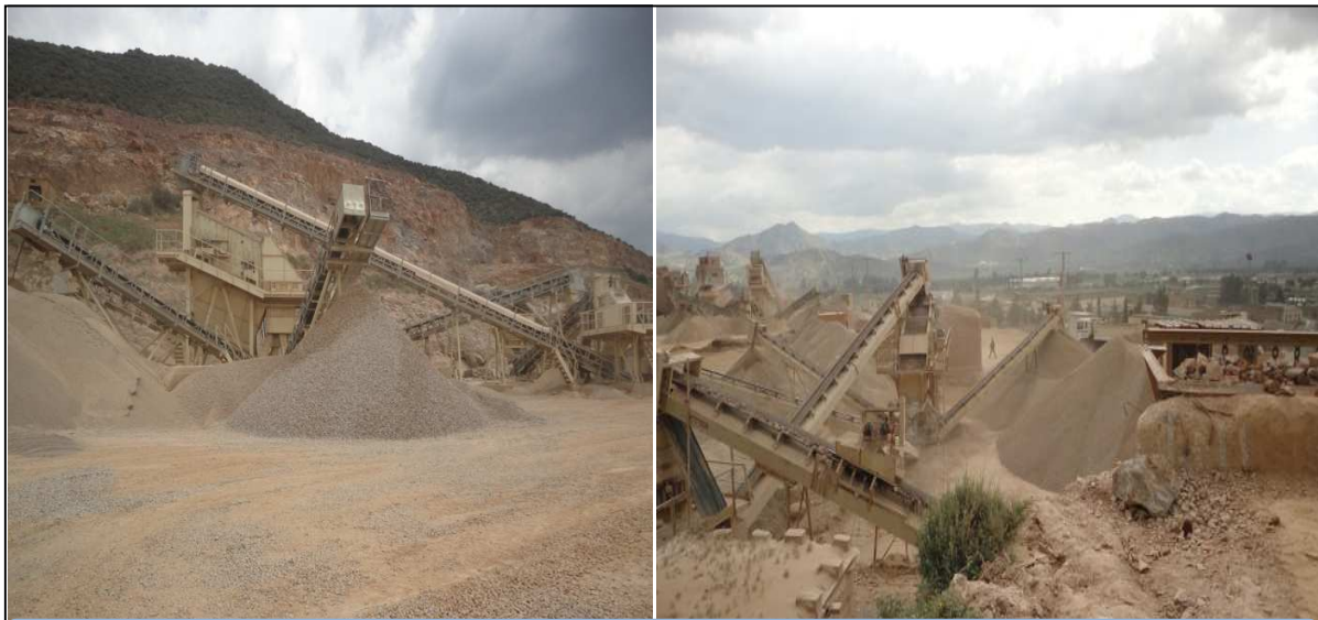
Figure 22 : Vue complète de la station de concassage de la SOMACOB-Akbou
