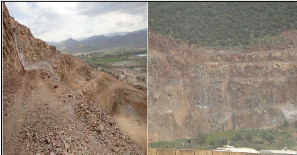
Figure 12 : Vue générale des gradins de la carrière de SOMACOB Akbou
