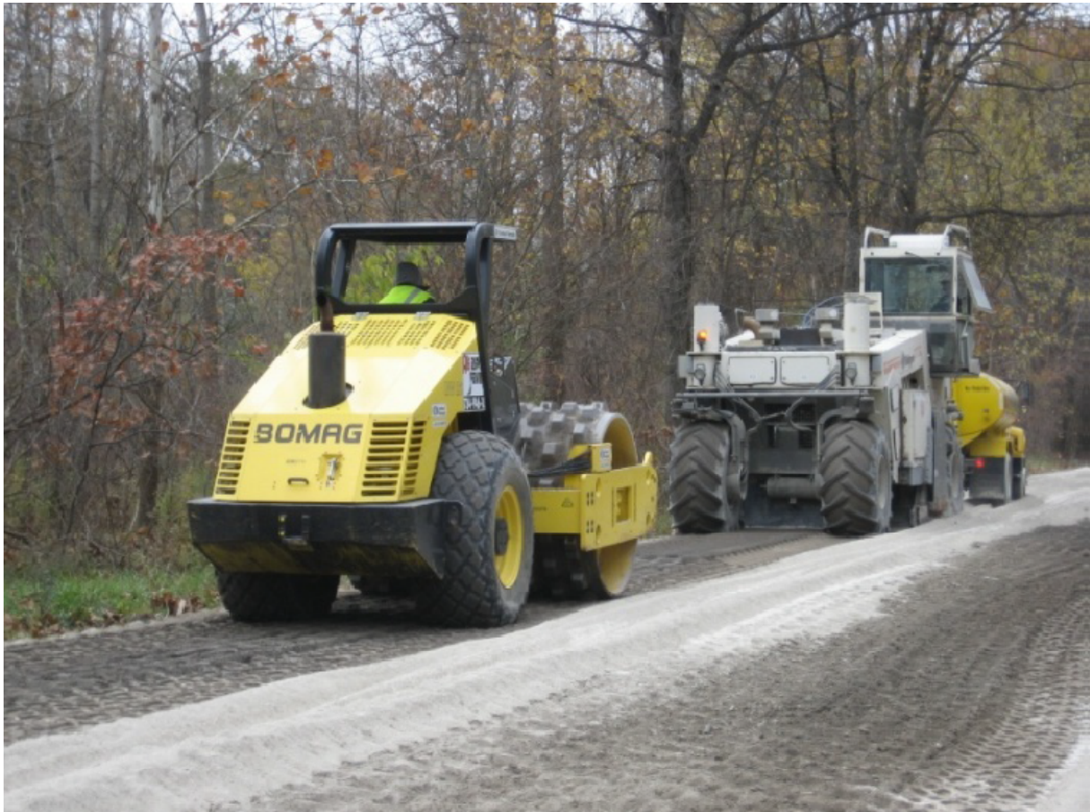
Figure I.04 : Construction d'un revêtement de base en utilisant le CKD (l'Amérique).
