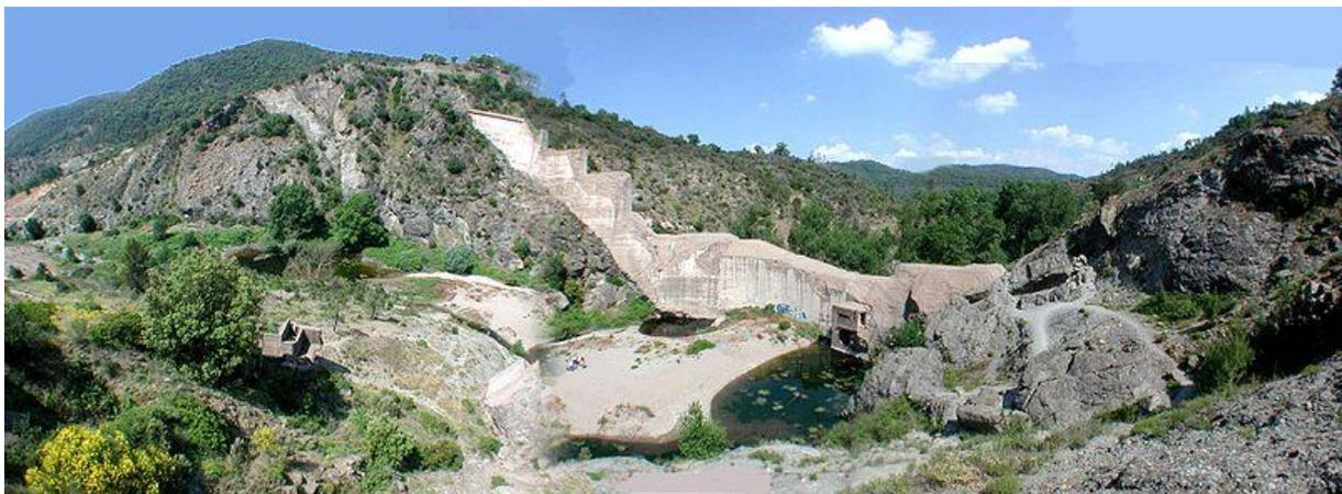
**Figure (1.16) :** Etat du barrage de Malpasset après la rupture
