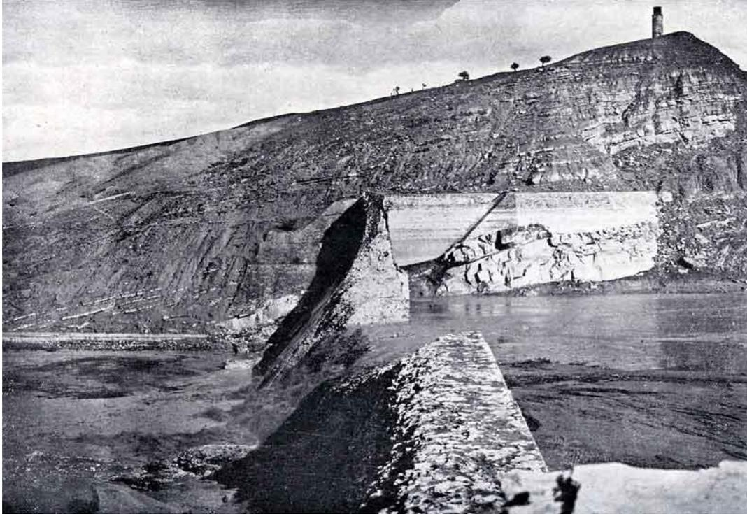
**Figure (1.12) :** Vue du Barrage Fergoug après la rupture du 25 novembre 1927
