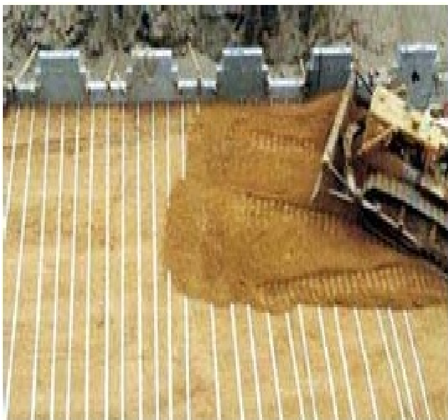
Figure I.3: Pose des armatures longitudinales dans le remblai
