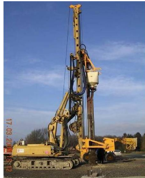
Figure 6-7 Grue portant le vibreur à sas
