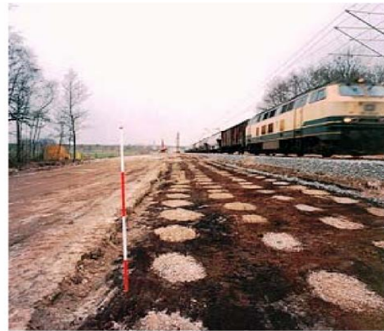
Figure 6-3 Fond de fouille après réalisation des colonnes ballastées
