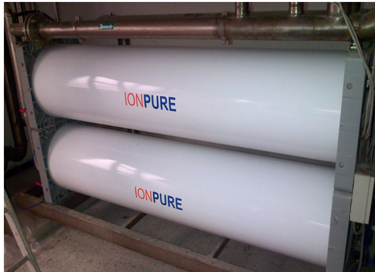
Figure III.5 : La face externe des modules d’CEDI utilisée au niveau de Cevital.
