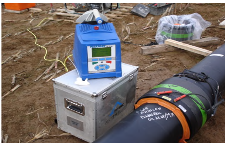
Figure (VII.21) : l'électro-soudage
