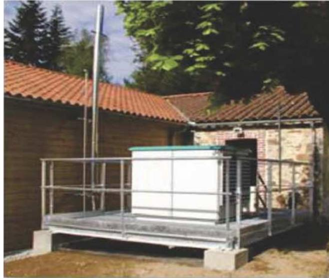
Figure **Erreur ! Il n'y a pas de texte répondant à ce style dans ce document..3** Photographie de la pile à combustible de type PEMFC (Limoges, projet EPACOP)
