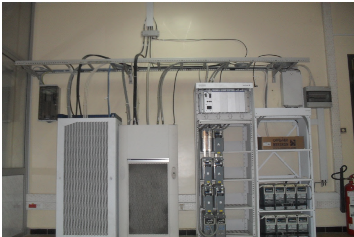
Figure I.8 : Exemple d'un RNC lié à un NODE-b
