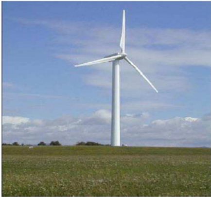
Eolienne à axe horizontal
