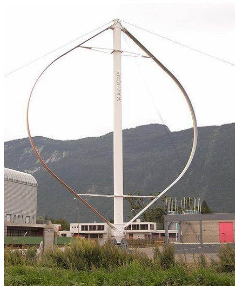
Figure I.8 - Eolienne à axe verticale de type Darrieus
