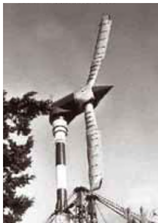
FIG I.3 : Eolienne de 100 kW de grand vent
