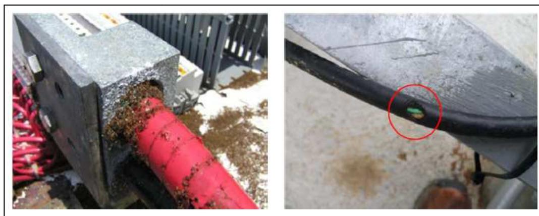
**Fig.III.8 :** Exemples de défauts rencontrés dans le câblage
