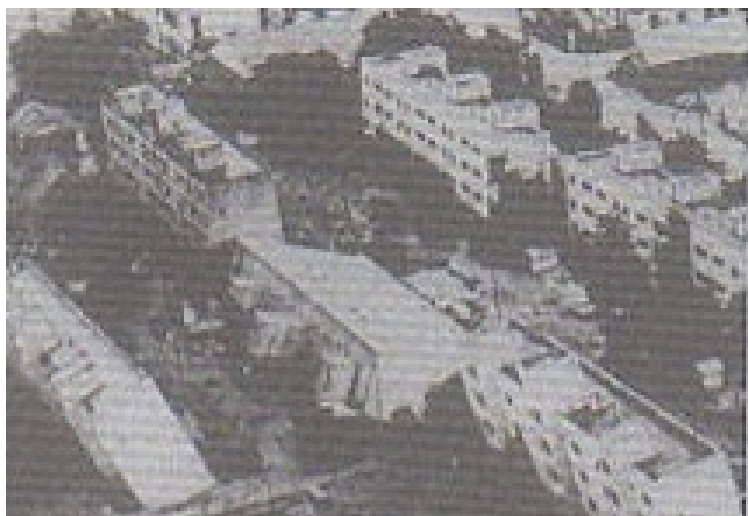
FIG. 1.9: Liquifaction de sol dans un milieu urbain
